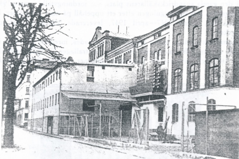
Fasaden mot Fabriksgatan efter senaste tillbyggnaden
