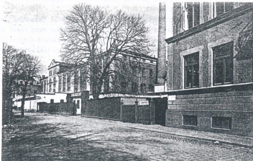
Bryggeriet (före senaste ombyggnaden) samt kontorsbyggnaden (närmast)
