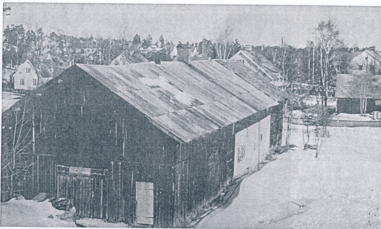
I denna byggnad som tillhörde Erik Dahlblom startade Öby Bryggeri 1925. Dahlbloms hade kommit till Öby 1924. I den del där fasaden är murad hade Reinhold Hägglund sin bryggerirörelse. Längst till höger i bild syns övervåningen på huset som Hägglund uppförde omkring 1930. Till vänster om detta hus kan man skymta det nya bryggeriet som blev klart 1931. "Dahlbolms uthus" revs för ett tjugotal år sedan och på platsen uppfördes Mikaelsgården, som står där idag. Foto: Rutger Hedblom 1961.
