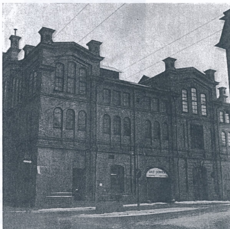
Västfasaden av f. d. Nürnbergs Bryggeri 1956.
