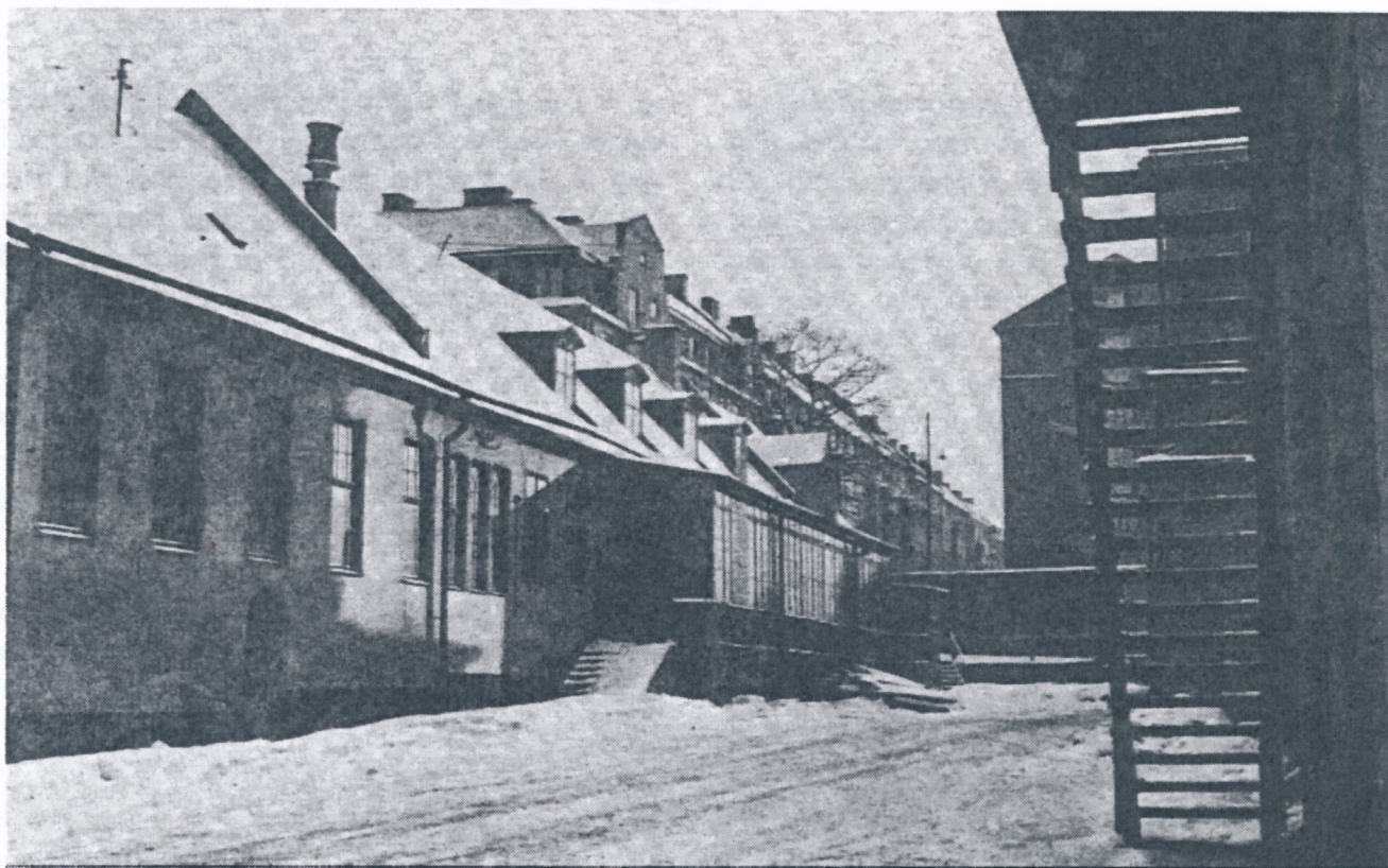
Tyska Bryggeriet från gårdsidan. Huset i bakgrunden, något dolt av stegen, visar den plats där Stockholms första tivoli låg.
