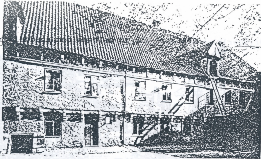
Bryggarnas lagshus i Malmö, beläget vid hörnet av Väster- och Långgårdsgatorna; rivet år 1900.
