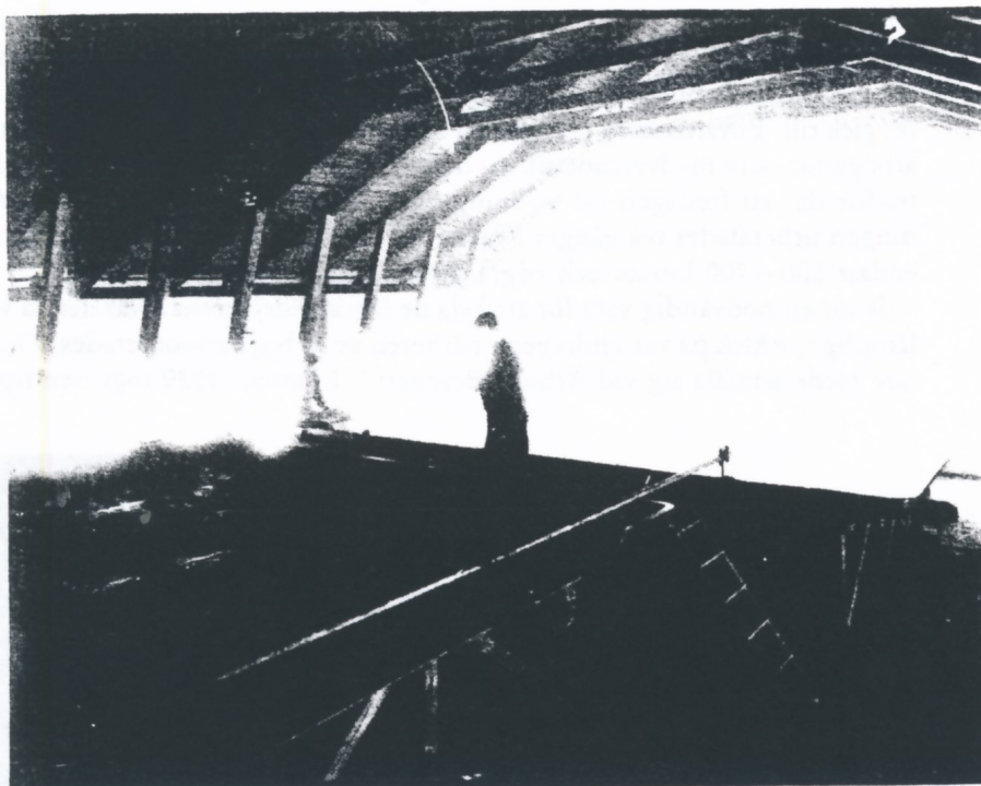
Arboga Bryggeri i början av 1900-talet: Kylskeppet beläget högst upp mot norr. Hit pumpades ölet efter bryggningen för att bli nerkyllt av luftväxlingen genom jalusifönstren, innan det gick vidare till jäskaren.
