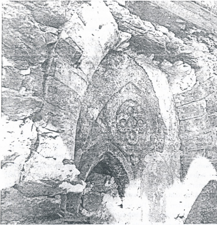
Medeltida fönsteröppning under framtagnig på gaveln mot Strandgatan i bryggeriets hus i kvarteret Fregatten
