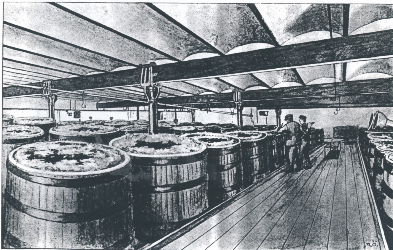
INTERIÖR FRÅN JÄSKÄLLAREN.
